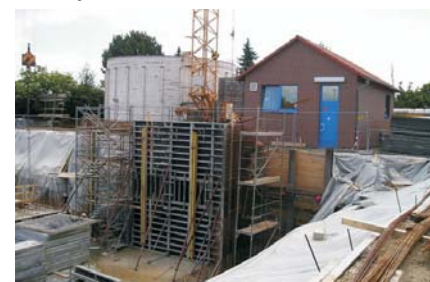
Baugrubensicherung Maschinengebäude
