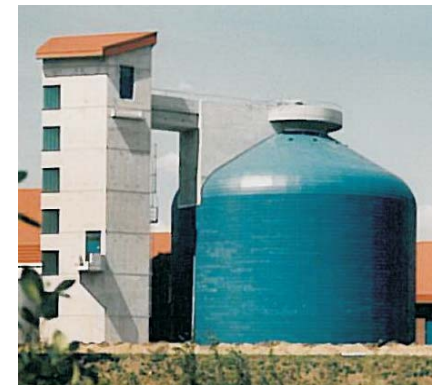
Faulturm mit Treppenturm
