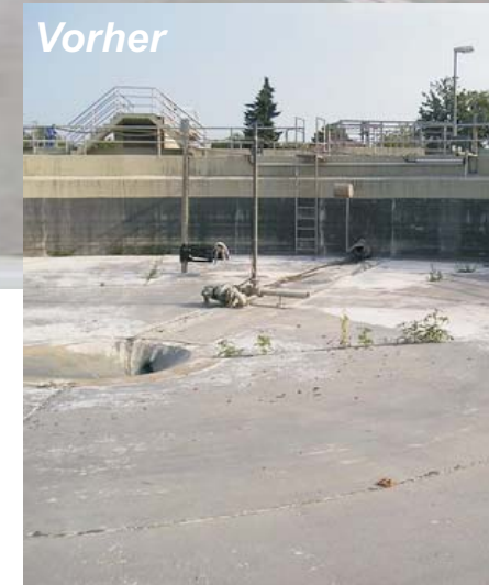
Undichte Dehnfugen im Speicherbecken
